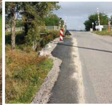
Sécurisation Route de Bellegarde : enrochement et reprise d'enrobé vers le passage à niveau
