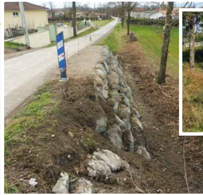
Sécurisation Route de Bellegarde : enrochement et reprise d'enrobé vers le passage à niveau
