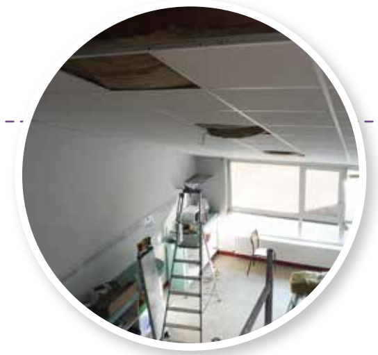
Isolation et remplacement des huisseries d'une salle de classe et aménagement de la garderie
