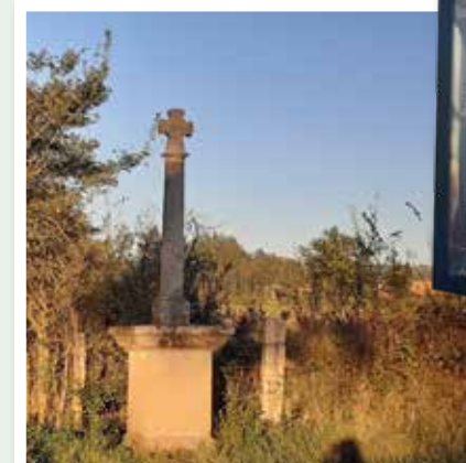
Réfection croisillon Route de Saint Galmier
