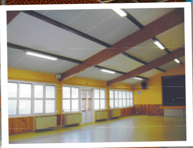
Salle de l'ERA Réfection totale du plafond de la salle de l'ERA
